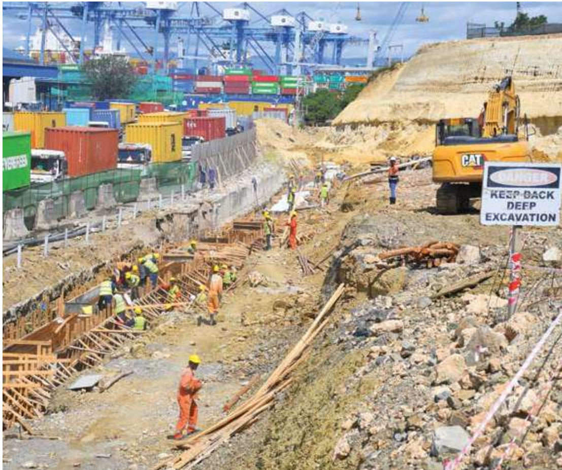
Sehemu ya ujenzi unaoendelea wa kupanua barabara ya bandari—mradi uliopendekezwa—kuanzia karakana ya mitambo ya 'gantry' hadi malango namba 18 na 20 katika Mamlaka ya Bandari ya Kenya (KPA), Mombasa. PICHA: ANDREW HINGA
