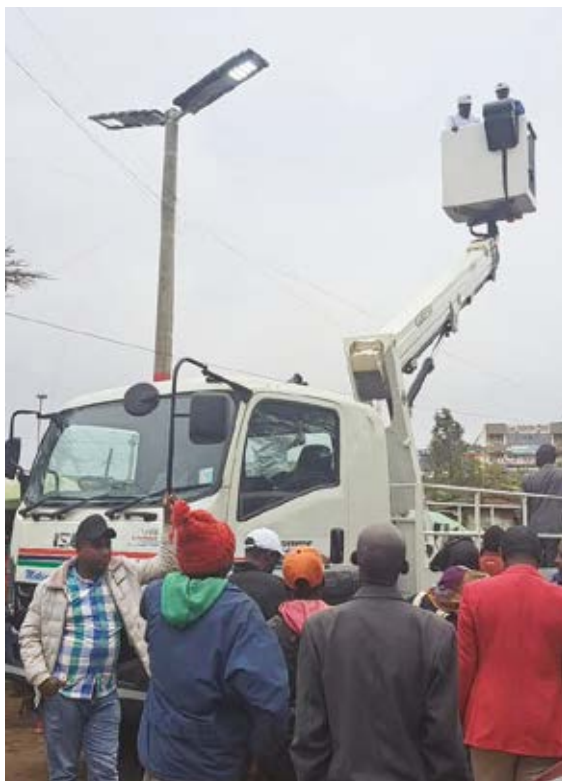
Kreni ya mita 23 katika Kiambu, inayosaidia uwekaji wa taa za barabarani na matengenezo kwa usalama wa maeneo ya umma.
