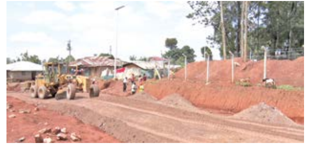
Ujenzi wa barabara unaoendelea kuboresha mitaa wa mabanda wa Amalemba chini ya mradi wa KISIP 2. Picha na Moses Wekesa, KNA.
