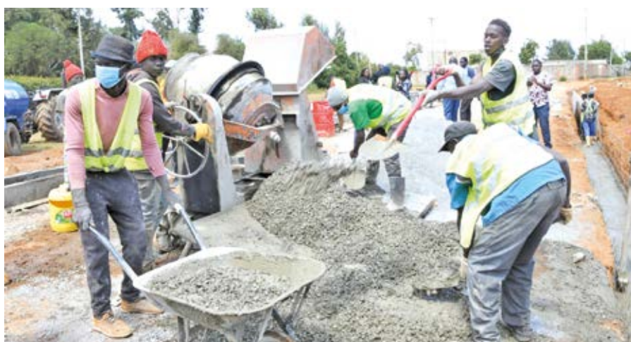
Mafundi wakiendelea na kazi ya kuboresha mitaa duni katika Kaunti ya Uasin Gishu chini ya mradi wa KISIP II.
