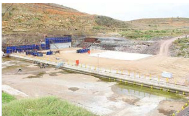
Ujenzi wa bwawa la Mwache unaendelea katika Kaunti Ndogo ya Kinango, Kwale.
