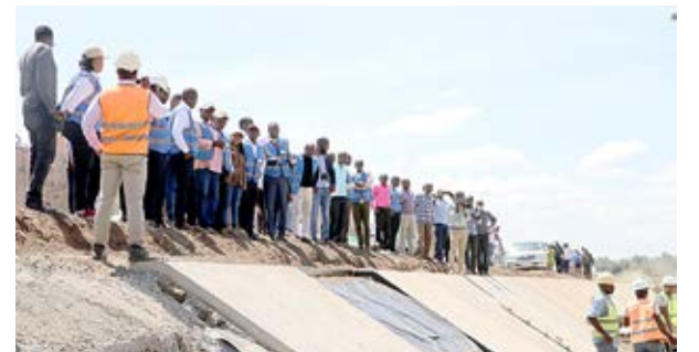
Maafisa kutoka National Irrigation Authority waungana na Katibu kukagua ujenzi wa mitaro.
