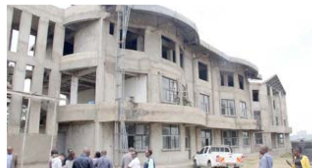
Sehemu ya jengo la Lake Victoria Basin Commission (LVBC) mjini Kisumu.
