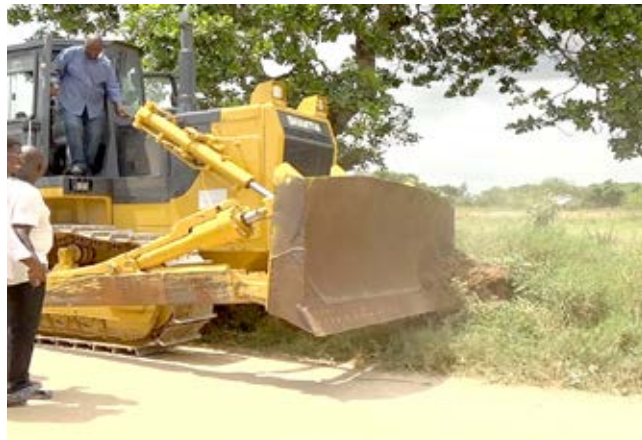
Tingatinga yaanza kazi ya ujenzi katika awamu ya pili ya barabara ya Goshi-Madunguni katika Wadi ya Kakuyuni ya Kaunti Ndogo ya Malindi, Kaunti ya Kilifi.
