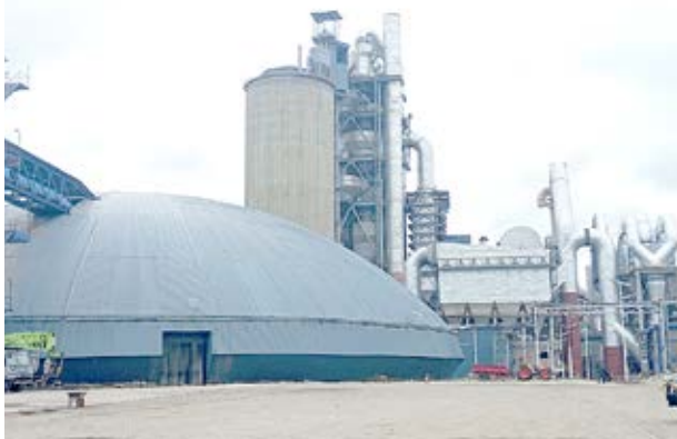
Mtazamo wa kando wa Kampuni ya Uzalishaji wa Saruji huko Sebit iliyojengwa na Kampuni za Devki katika Kaunti Ndogo ya Kipkomo katika Kaunti ya Pokot Magharibi. Picha Na Anthony Melly
